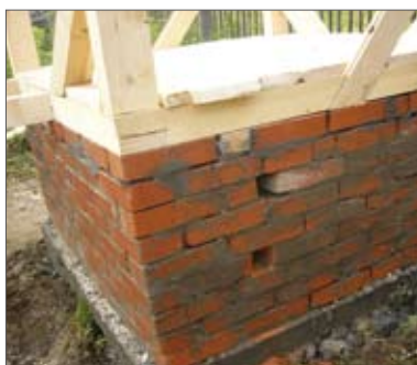
Фиг.4: Строеж на външните тухлени стени на фекалните камери (ляво), отвор за тръбата с урината (дясно)
