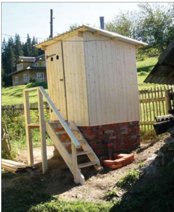
Фиг. 1: Суха разделна тоалетна с две камери: изглед отвън (ляво) и изглед отвътре (дясно).
